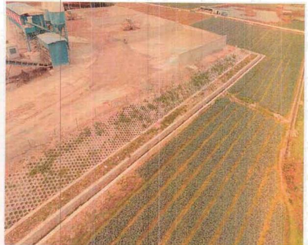
**K4+300** 停车区边坡实施六棱块护坡并植草防护，坡脚修建了排水沟
