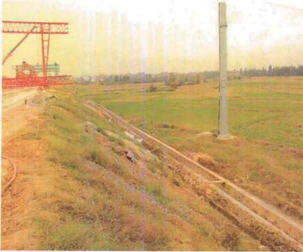
**K1+200** 右侧填方边坡已修建排水沟
